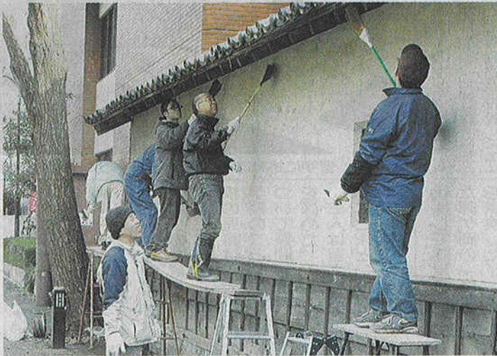
「ござ九」の壁の補修作業に汗を流すおもてなしプラザ運営協議会のメンバーら
